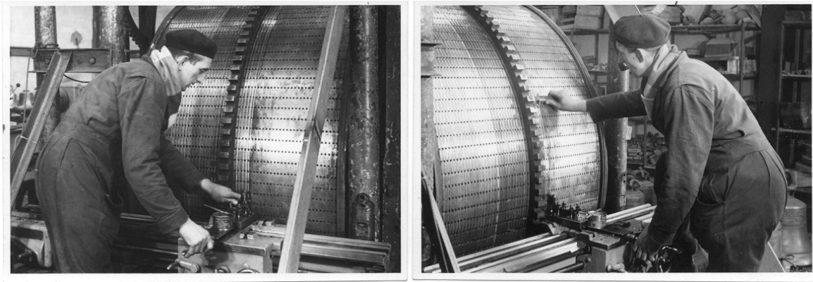
Afb.3: Het indraaien van banen voor schuifnoten in de Haagse speeltrommel (1689) door de draaier Jan Feyen bij de Koninklijke Eijsbouts te Asten in 1956. Daarbij werd de speeltrommel door een motor aangedreven en een draaibank voor de trommel geplaatst
