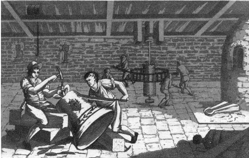
Afb.8: In het midden op de achtergrond aandrijving door mankracht van een boor voor het op kaliber brengen van een stuk geschut (18de-eeuwse prent van onbekende herkomst).
