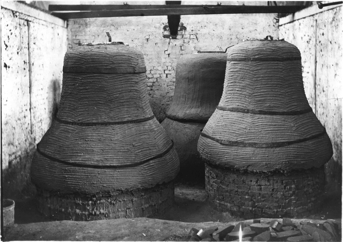
Enkele voltooide mantels met hoepels in 1916 bij de Koninklijke Klokkengieterij Petit & Fritsen te Aarle-Rixtel.
