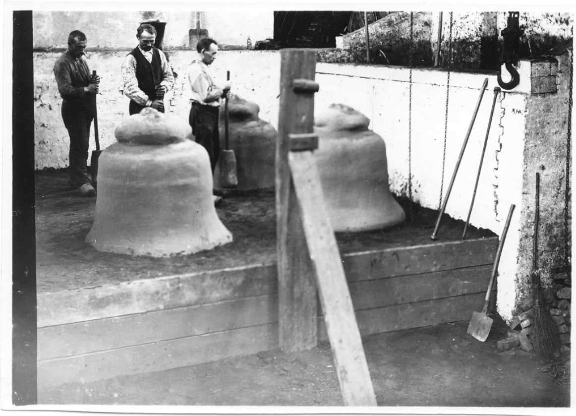
De klokkenvormen worden in 1916 bij de Koninklijke Klokkengieterij Petit & Fritsen te Aarle-Rixtel in de gietkuil opgestampt.
